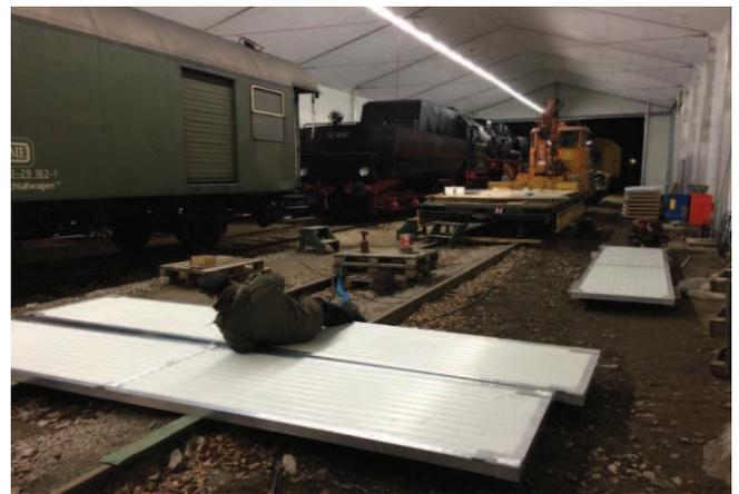
Zahlreiche Alu-Verbindungen werdend genau zugeschnitten und exakt mit Bohrlöchern versehen und mit den Platten verschraubt
