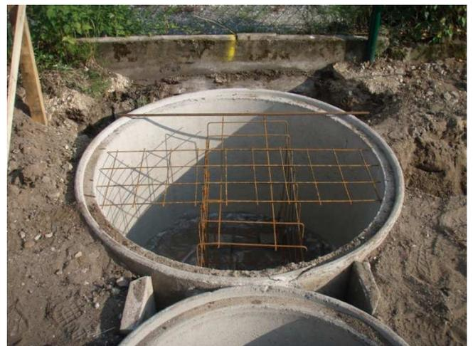
Schachtringe in den Boden eingelassen. Diese werden in Kürze mit Beton ausge-
